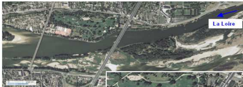
Viaduc A10 à Tours sur la Loire
